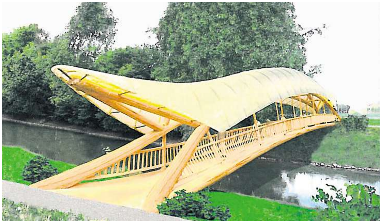
Ausschliesslich Schweizer Unternehmen wurden für die Arbeiten am Aubrüggli berücksichtigt. Das Projekt kostet 850 000 Franken.
