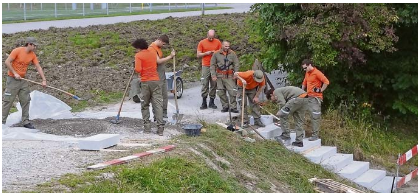
Zivilschützer erstellen die Treppen an der neuen Holzbrücke an der Glatt.
